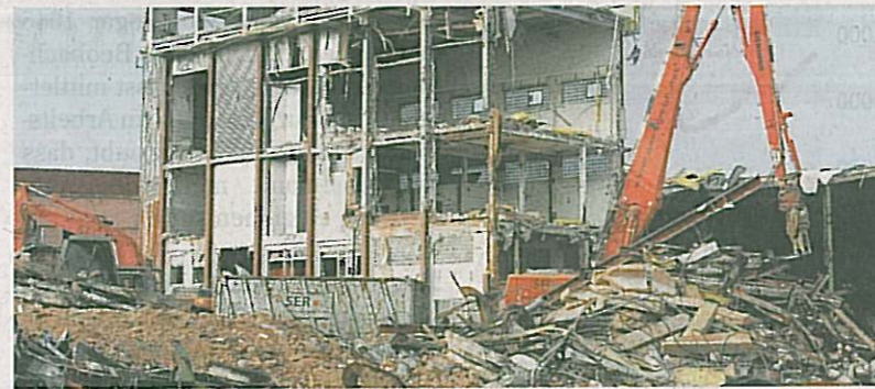
Bauschutt, halb abgerissene Lagerhallen: Dort, wo einst 350 Leute arbeiteten, soll demnächst kein Stein mehr auf dem anderen stehen.
