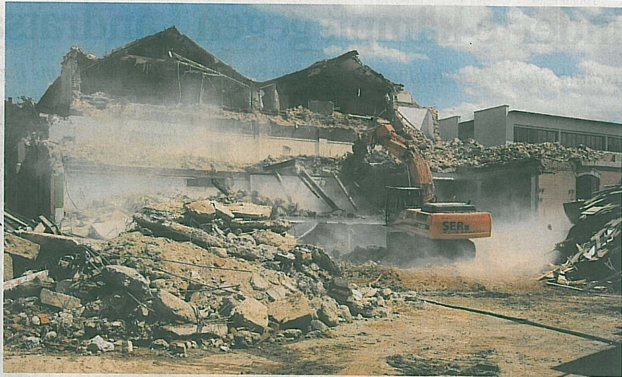
An der Mannheimer Straße werden die letzten Bauzeugen der Schaeffelen'schen Papierfabrik abgerissen. Bekannt wurden die Backsteingebäude auch durch den Nutzer Möbel Fritzsch. Ende 2011 soll hier ein Hochschulcampus stehen. Foto: Dittmar Dirks
