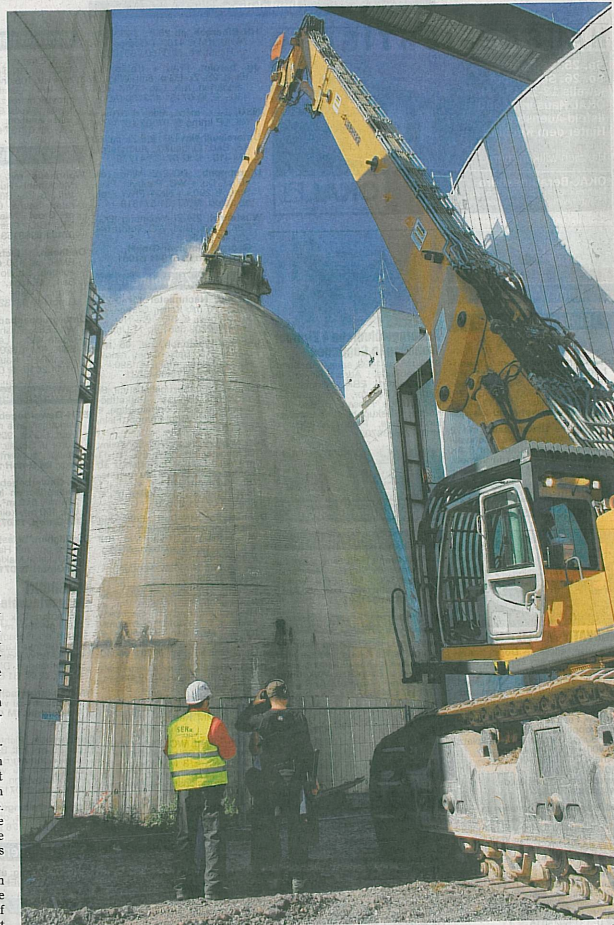
Zentimeterarbeit mit einem 42 Meter langen Arm. Per Funk bekommt der Baggerfahrer Anweisungen, was er als nächstes tun muss. Die Gebäude rechts und links der Baumaschine müssen unversehrt bleiben.
