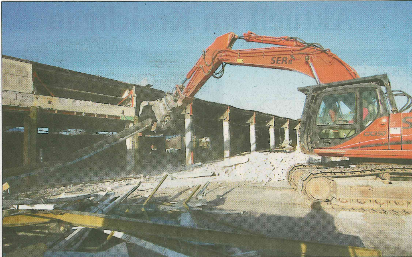
Abgerissen wird der bisherige REWE-Markt in der Riemenstraße. Hier kommt der neue Aldi-Discounter hin. Foto: Endres
