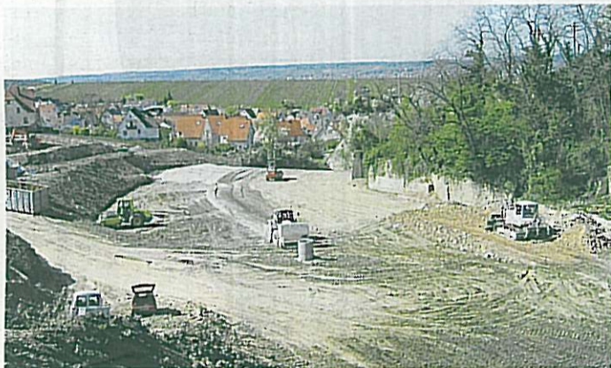
Der Erdeinbau erfolgt gemäß einem Qualitätssicherungsplan. Die Material- und Einbaugüte wird durch einen Fachingenieur überwacht.
