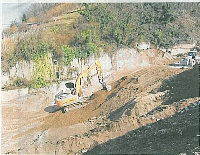
Durch die Auffüllung der Klinge können wesentliche Erschwernisse im Zuge der Erschließung des Wohngebietes elegant gelöst werden.
