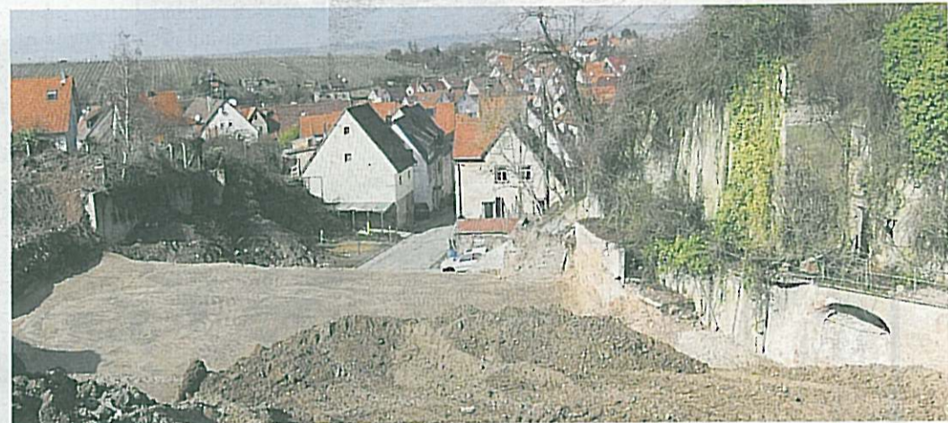
Der Erdeinbau erfolgt gemäß einem Qualitätssicherungsplan. Die Material- und Einbaugüte wird durch einen Fachingenieur überwacht.
